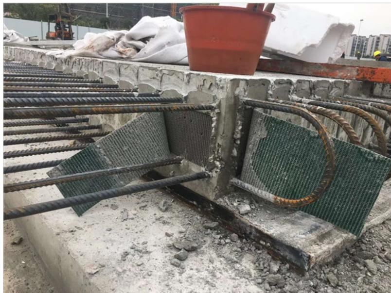
免凿毛止浆带质优价廉混凝土表面凿毛是为了解决混凝土接层粘结问题，无论是桥梁构件、桥墩或浇筑铰缝及桥面铺装前毛勒缝槽口等结合部，或水泥混凝土坝、核电站、港口码头、道路桥梁高铁、水电站闸墩等水泥混凝土工程的施工还是加固这些工程。凿毛的目的都是为了使新老水泥混凝土之间能够形成一个整体。被凿击后的表面不但要去除浮浆还应形成凹凸麻面，而不是一个平整的毛面，只有这样新老混凝土才能黏合为一个整体。通常凿毛一般采用凿毛机、铣刨机等大型设备。而有些施工部位空间有限不能采用机械凿除，用人工凿除时比较费时费力，而且效率比较低，电镐、风镐的冲击力损伤构筑物低层结构，使工程留下隐患。绿色免凿毛止浆带是一种新型的复合材料，可以根据现场需要制作成各种尺寸。施工方便而且可以重复使用。绿色免凿毛止浆带在使用时需要注意，在混凝土初凝后及时拆除止浆带防止过度凝固难以拆除。通常凿毛一般采用凿毛机、铣刨机等大型设备。而有些施工部位空间有限不能采用机械凿除，用人工凿除时比较费时费力，而且效率比较低，电镐、风镐的冲击力损伤构筑物低层结构，使工程留下隐患。绿色免凿毛止浆带是一种新型的复合材料，可以根据现场需要制作成各种尺寸。
